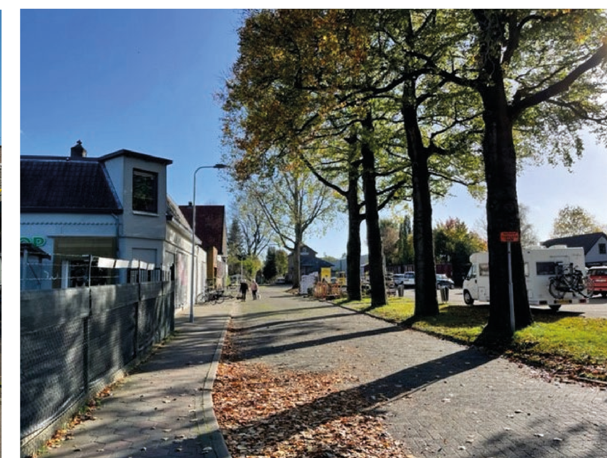
4 beuken voor de Welkoop: eerste twee (gezien vanaf Coldenhovenseweg) in slechte conditie. Levensverwachting van minder dan 5 jaar. Derde boom is in goede conditie en vierde in een matige conditie (levensverwachting ca 5 jaar).
