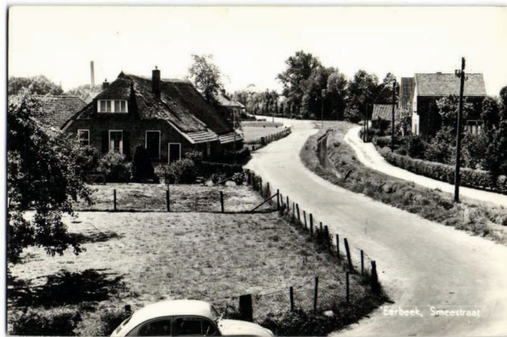
Mix van bebouw langs een van de linten van Eerbeek
