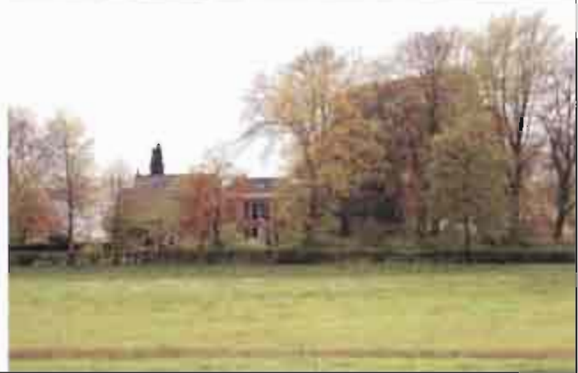
Bestaande situatie deelgebied Oeverwal
