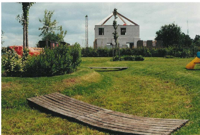
Afbeelding 12 Wadi's in Oikos – een bovengrondse infiltratievoorziening
