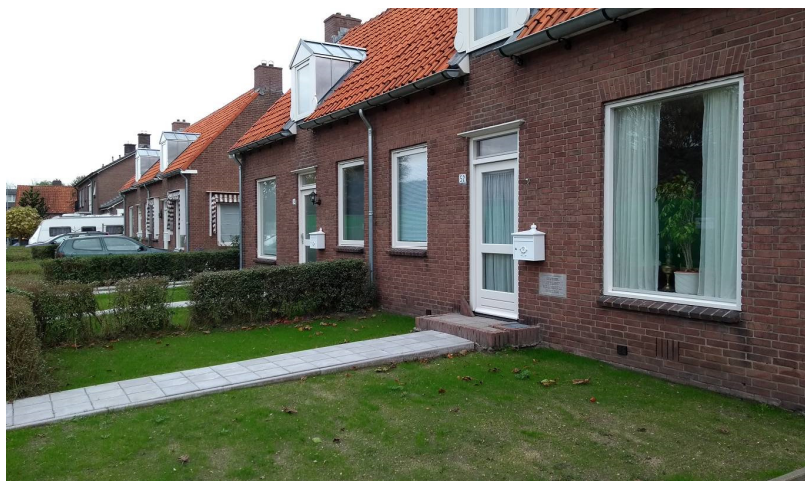
Renovatieproject Veluwonen aan de Volmolenweg.: Energieneutraal: 0-op-de-meter!
