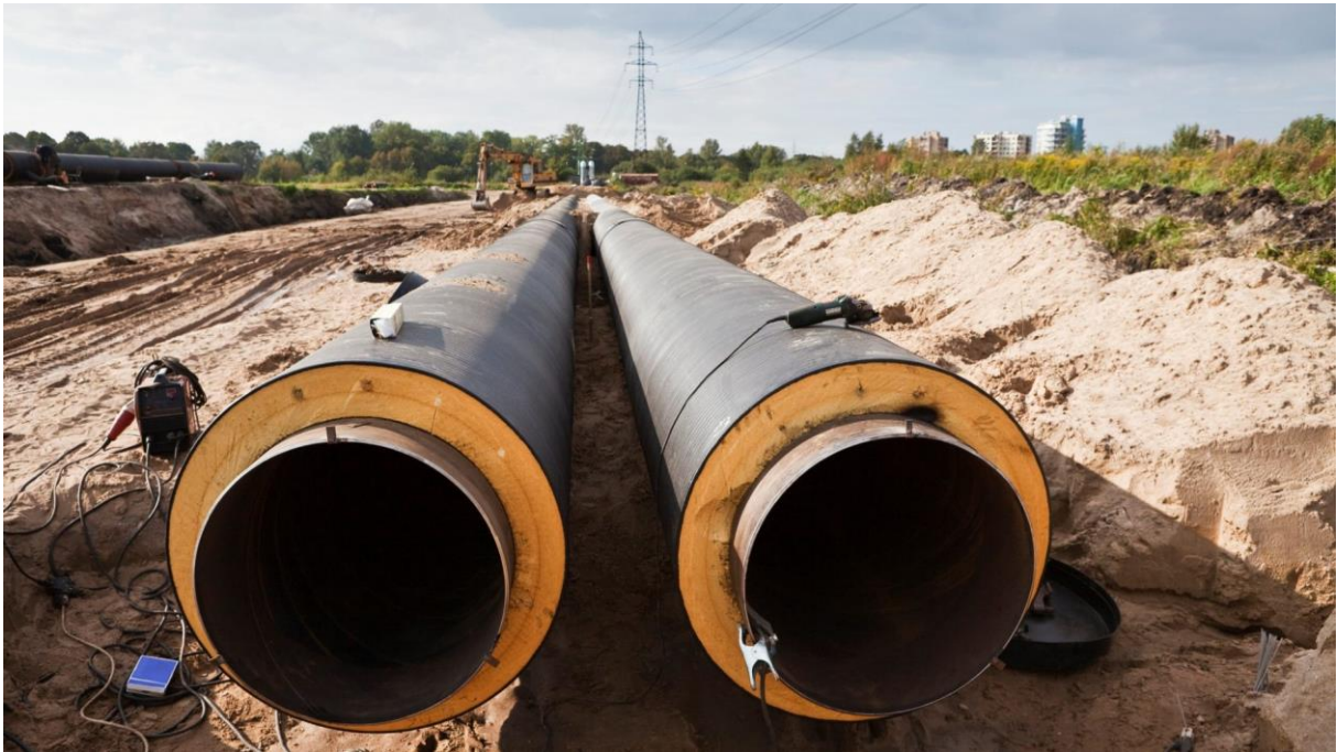
Warmtenetleidingen (bron: Stichting Zeeuwse Publieke Belangen)
