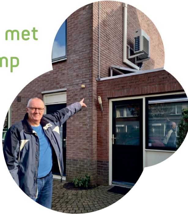
Energiecoach Hay Verstappen bij de buitenunit van zijn hybride warmtepomp aan de Savornin Lohmanstraat in Brummen.
