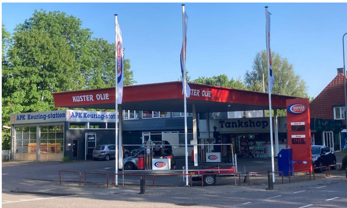
Het huidige tankstation aan de G.K. van Hogendorpstraat.
