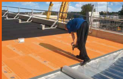
plat dak isolatie
