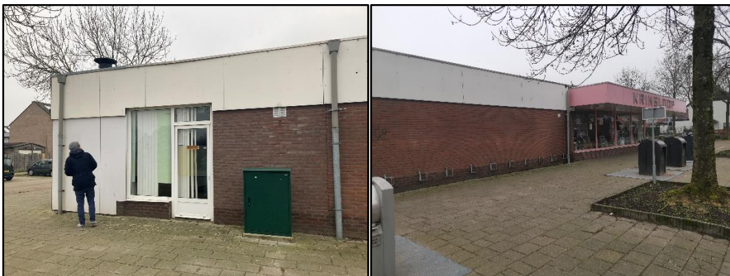
Figuur 2.7 (links): De noordwestzijde van het gebouw; Figuur 2.8 (rechts): De zuidwestzijde van het gebouw.
