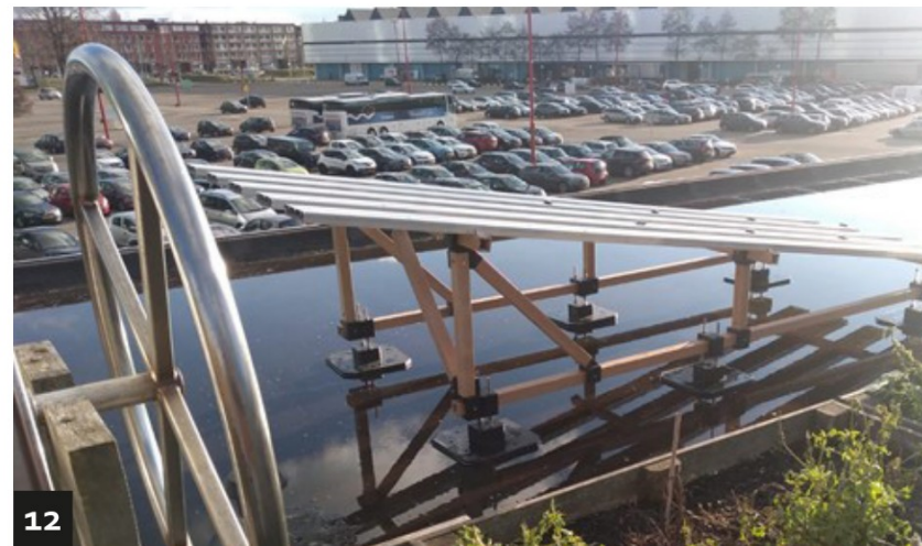
Referentiebeeld van bio-based onderconstructie.
