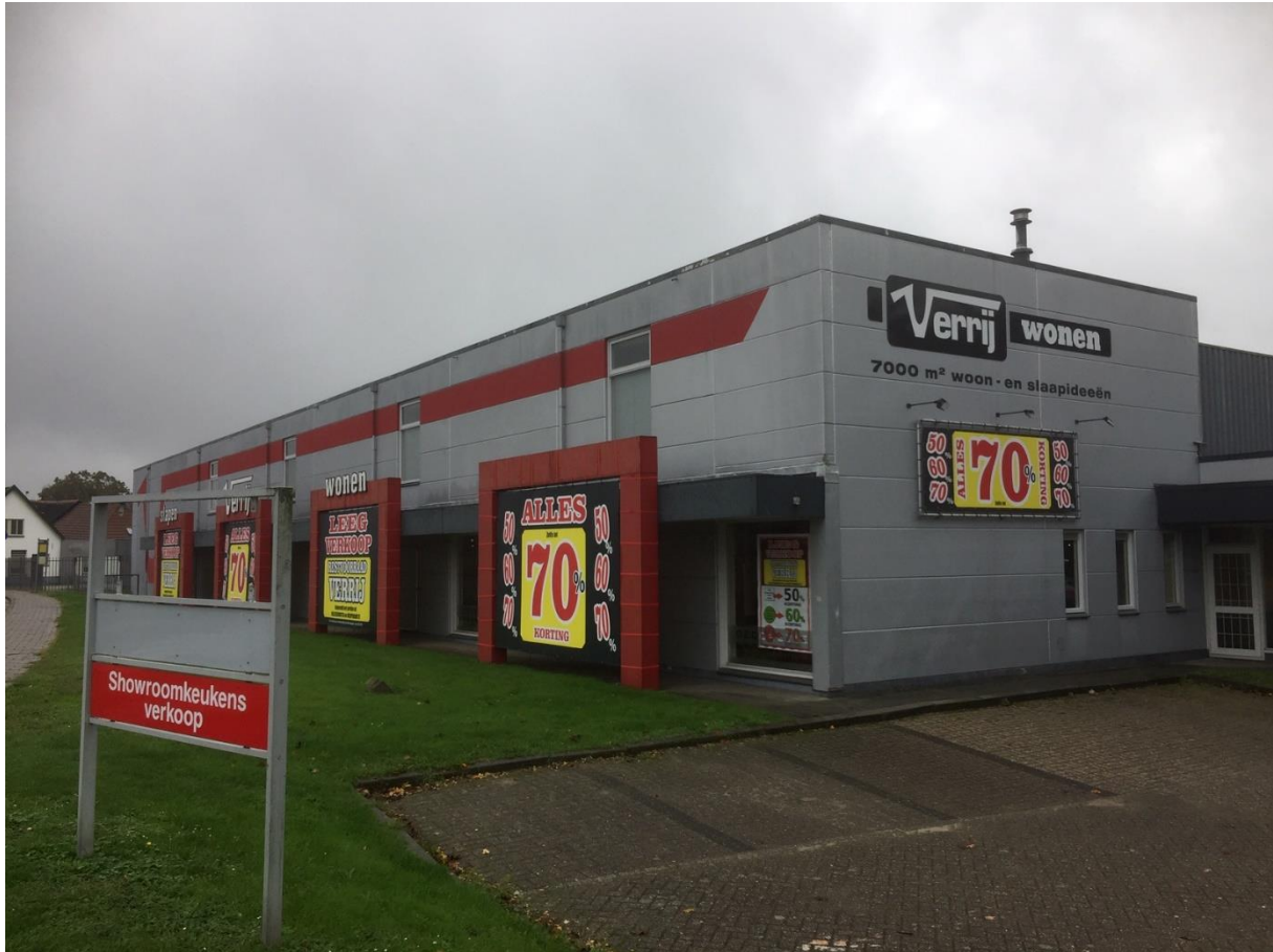
Figuur 3. Aspect van de te slopen meubelhal.
