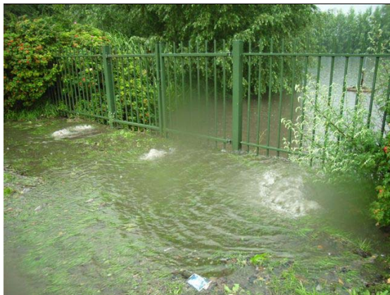
Figuur 4.4 Wateroverlast bij de retentievijver komt niet meer voor
