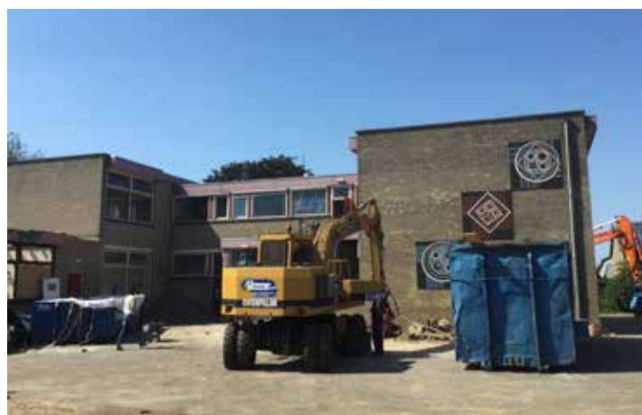
Op dit moment vindt sloop van het schoolgebouw De Enk plaats
