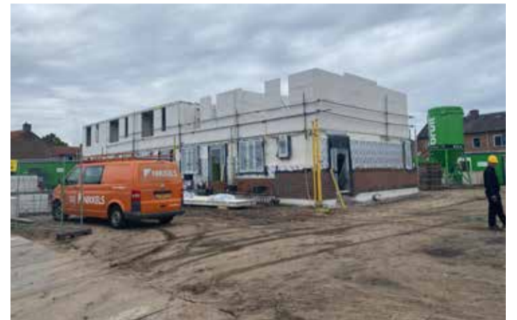
De bouw van 5 nieuwe huurhuizen in de Eerbeekse Enk
