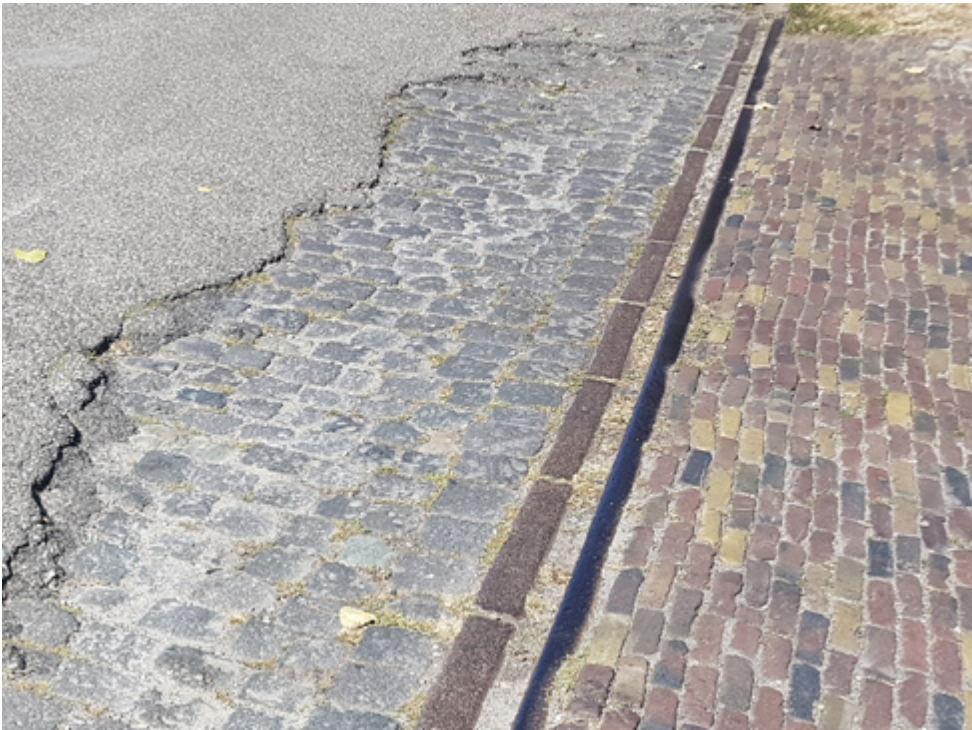
Onder het asfalt liggen de granietkeien te wachten.
