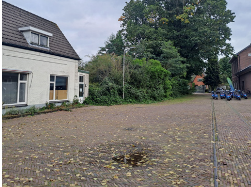
Verlaten woning tegenover het stationsgebouw. Stationsstraat 5 / 5a (is in eigendom gemeente).
