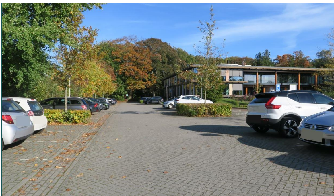
Figuur 1.1 De planlocatie is gelegen aan de Engelenburgerlaan 31 te Brummen.
