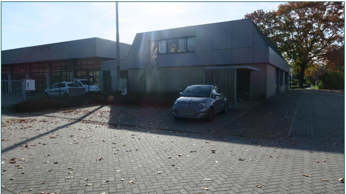
Figuur 4 Impressie van het parkeerterrein met op de achtergrond de brandweerkazerne. De gemetselde gevel beschikt over meerdere open stootvoegen.
