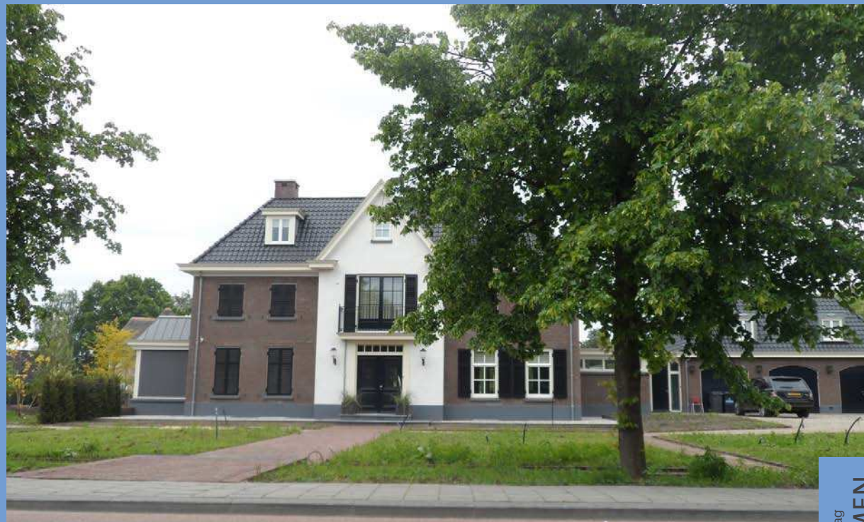
Recentelijke nieuwbouw van een villa in Brummen
