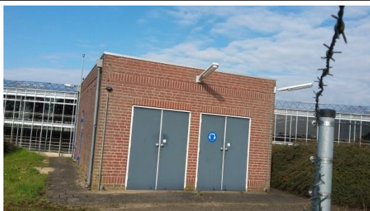
Gasontvangstation waarin potentiële verblijfplaatsen voor vleermuizen aanwezig zijn
