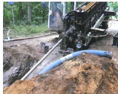
Met een boorteknik zijn de gas en retourwaterleiding onder wegen en zelfs onder een dassenburcht aangebracht. De overlast van de werkzaamheden is zo voor Eerbeek zeer beperkt gebleven.
