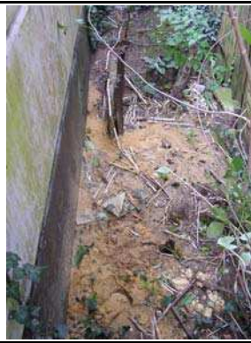
Foto b6.4 Asbest op maaiveld, boring ernaast
