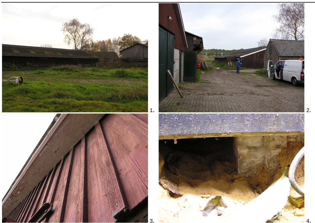
Foto 1 en 2: overzicht te slopen gebouwen
