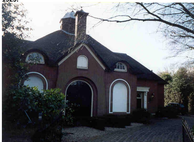
Afb. 16: Het voormalige koetshuis van Klein Engelenburg. (Foto: SB4, 2001)
