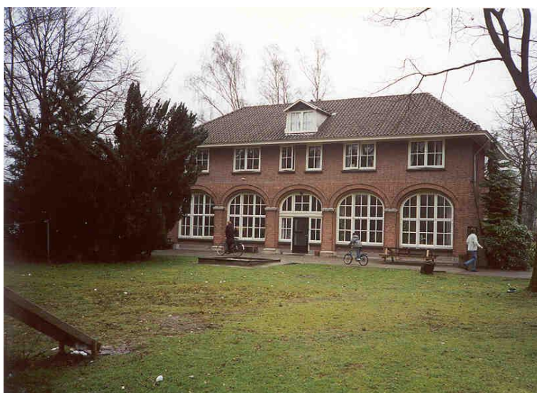
Afb. 36: De verbouwde orangerie. (Foto: SB4, 2001)
